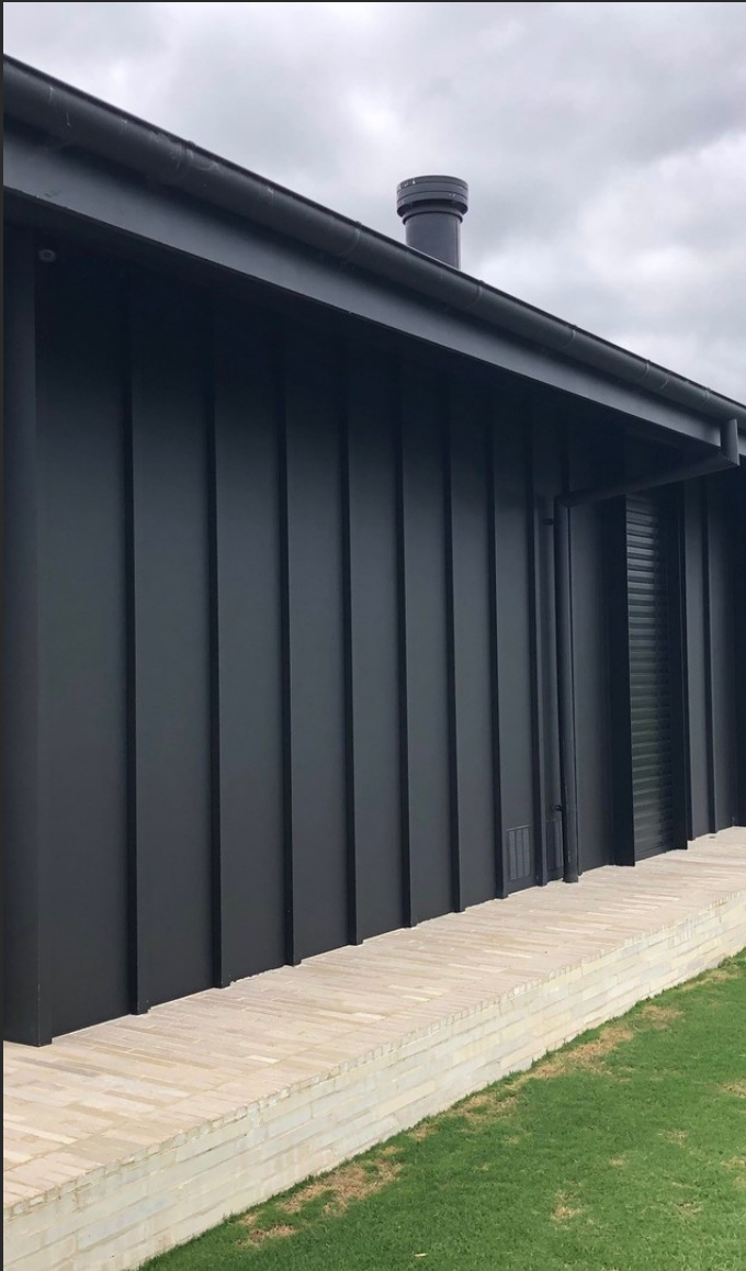
CONTOURED 93MM INTERLOCKING SLATS
